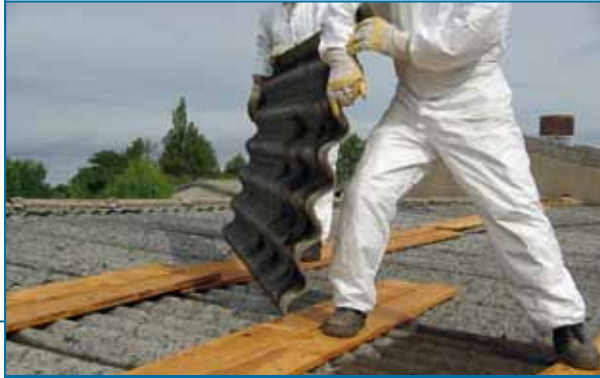
Operai al lavoro per rimuovere l'amianto
